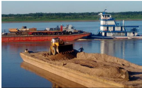
Rio Amazonas 2016: transportando agregado para obra “agua para CC.NN. Santa Ana”- PNSR.
